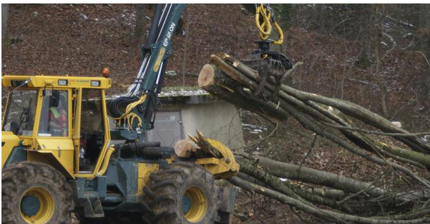
Nach der Fällung räumt der Kranschlepper die Baumstämme beiseite.
